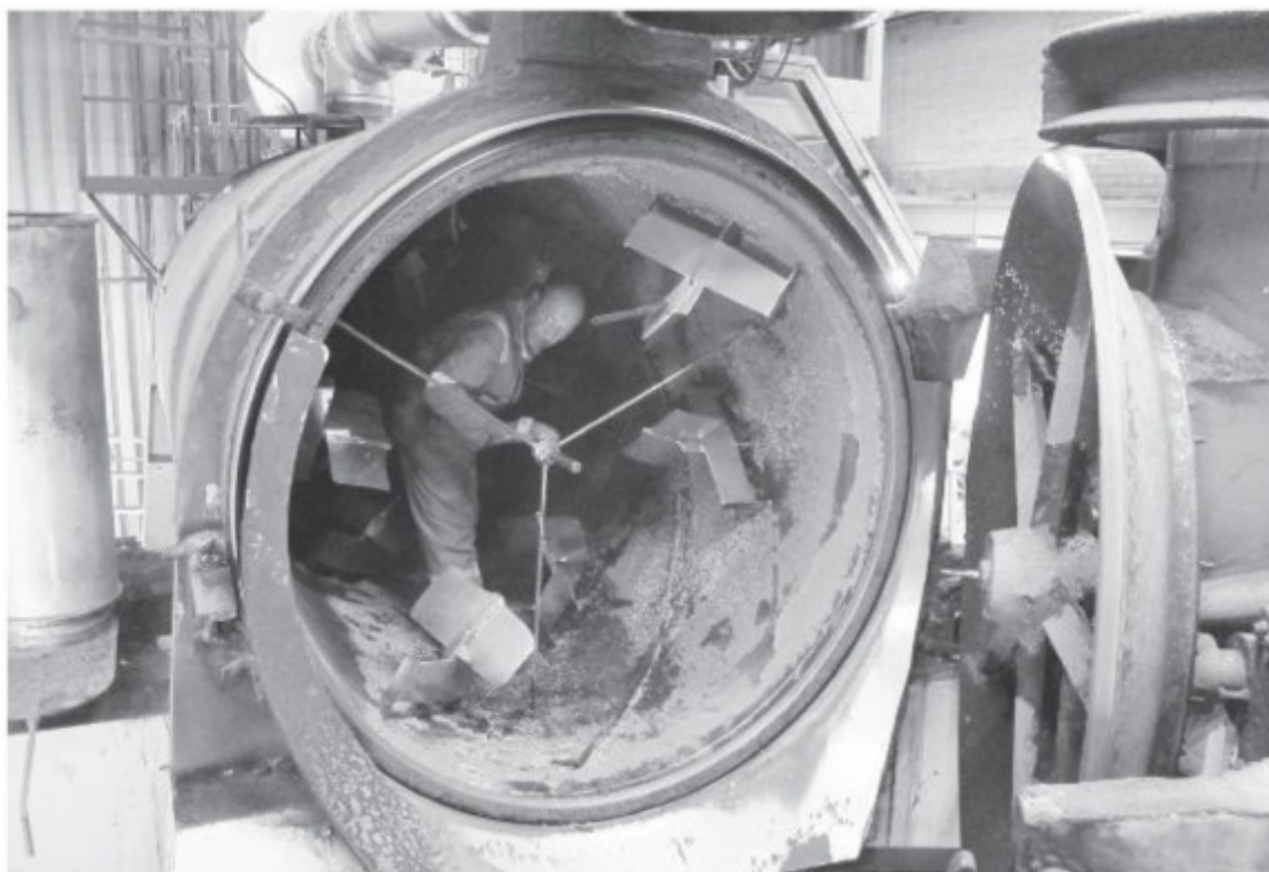
FIG. 5.1: Reparação de um rolamento dentro de um tambor de torrefação. Ele pode fazer até 2 toneladas métricas (4,410 libras) de malte torrado por lote. Observe as palhetas usadas para misturar o malte à medida que o tambor gira.
