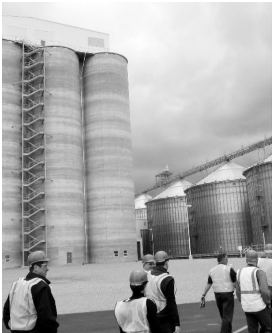
Caixas de armazenamento de cevada e malte no Integrow Malt, Idaho Falls, ID. As latas metálicas à direita podem armazenar 8.000 toneladas métricas (17.600.000 libras) de cevada cada.
